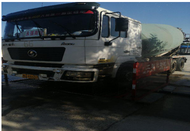
进出车辆冲洗设施
